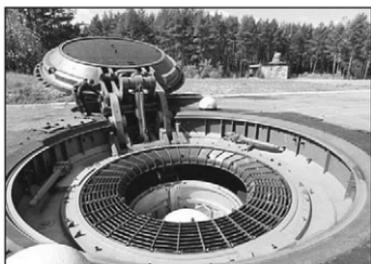
Современные шахтные пусковые установки обеспечивают защиту стартового комплекса от близкого ядерного взрыва
